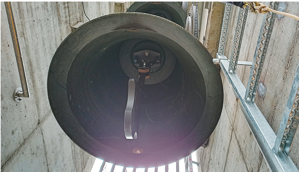
Der neue Ankerklöppel reduziert die Lärmbelastung deutlich, ohne den charakteristischen Klang der Glocke zu verändern.
