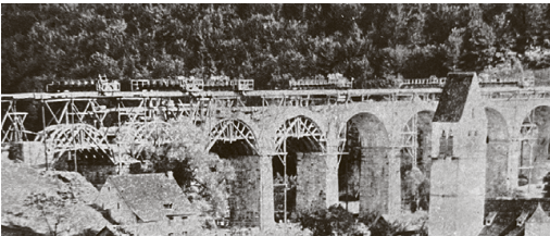
Der Bau des Rümlinger Viadukts. Historische Fotografie aus dem Jahr 1856.
