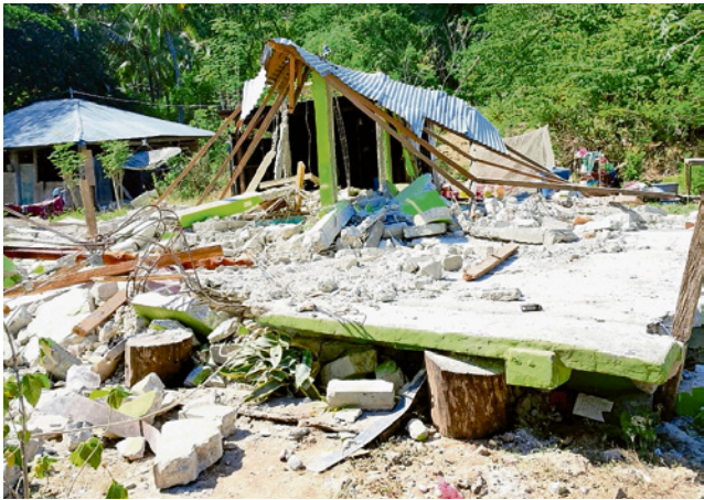
Indonesien: Die Schäden auf Flores sind teilweise massiv. zvg
