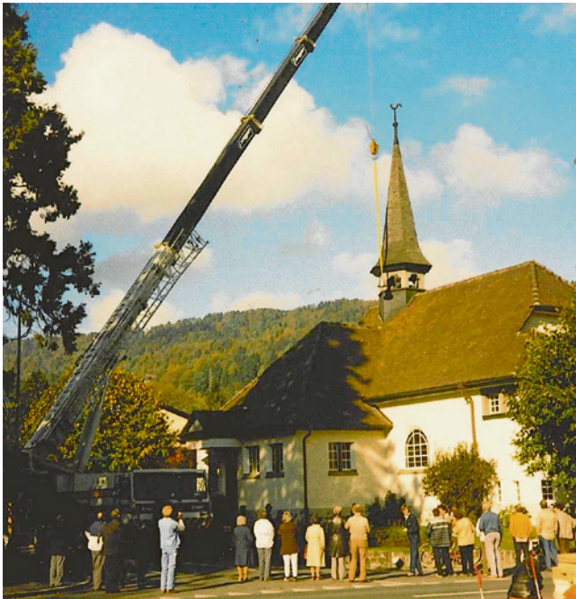
Aufzug der Glocken per Pneukran, Oktober 1986.
