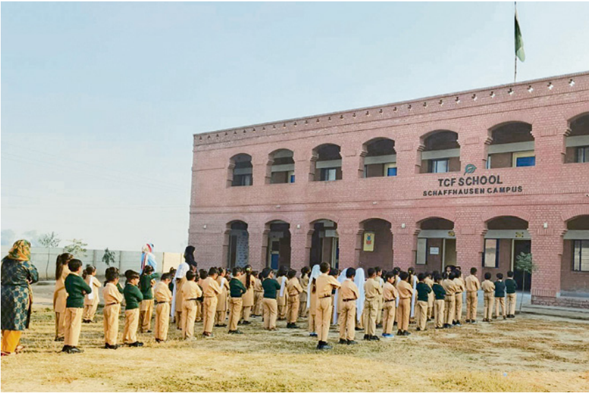
Auf dem neuen Schulgebäude steht gross «Schaffhausen Campus».
